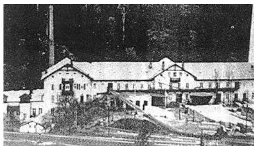
Die ehemalige Spuhmühle im Sebnitztal. Ca. 1880 bis 1937. Produzierte Bierdeckel und Buchbinderpappe. Export in viele Länder. Hatte einen eigenen Gleisanschluss.
